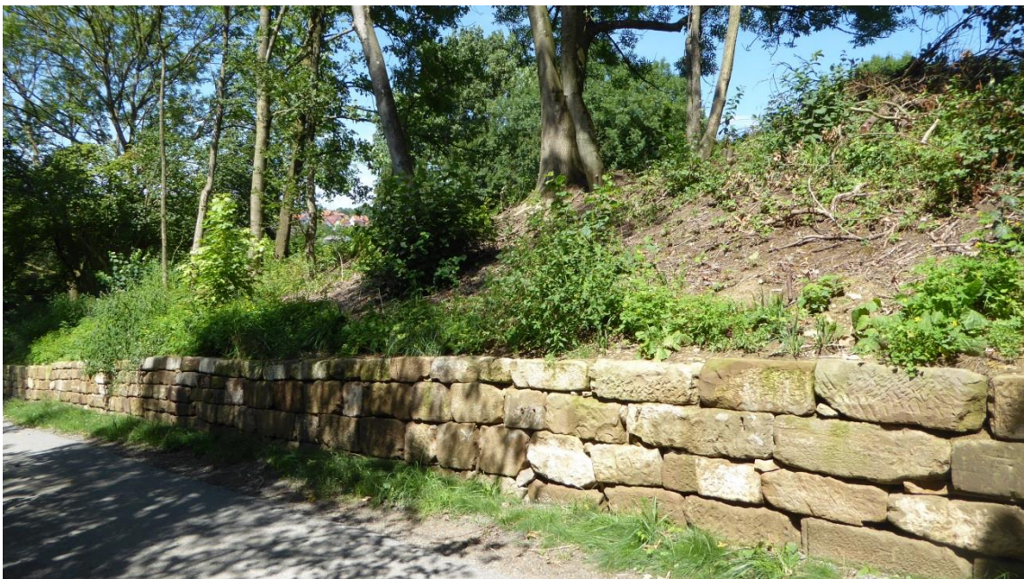
Abbildung 11: Sanierte und freigestellte Trockenmauer im Hohlweg 'Meersburger Straße'
